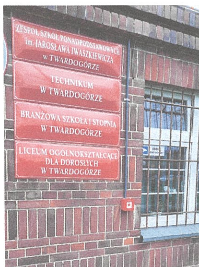
Rys. Uruchamianie przeciwpożarowego wyłącznika prądu
